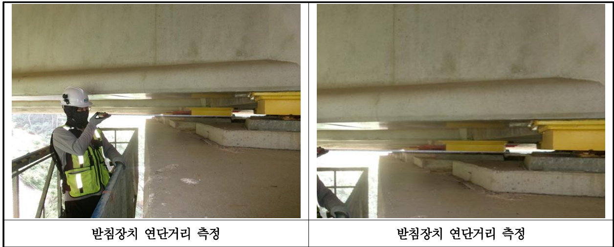
【사진 2.3.15】 교량받침장치 연단거리측정
