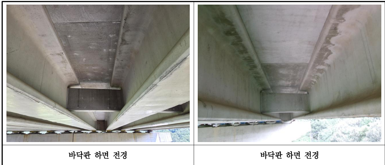
【사진 2.3.29】 바닥판하면 전경
