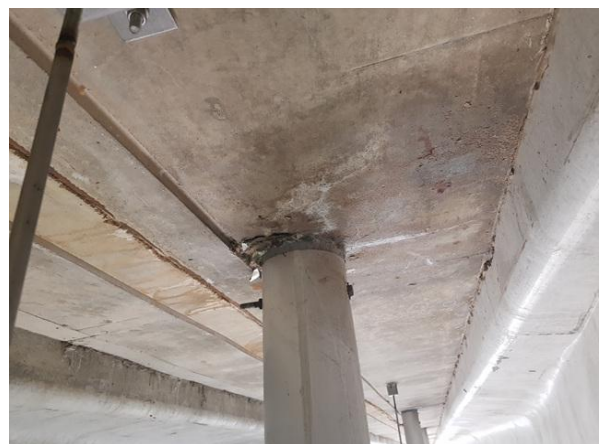
중분대 하면 상태양호
