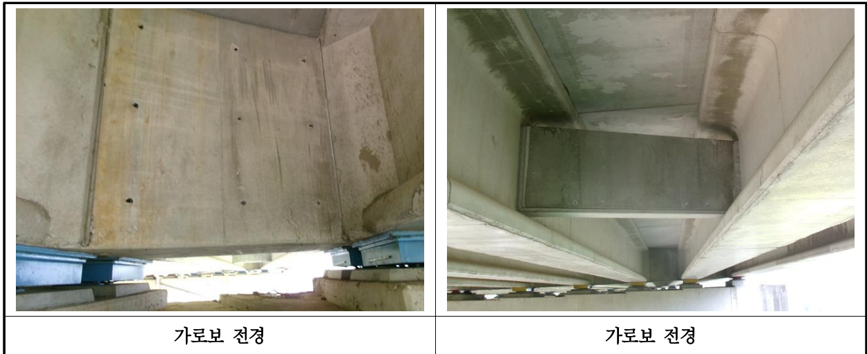
【사진 2.3.6】 가로보 전경
