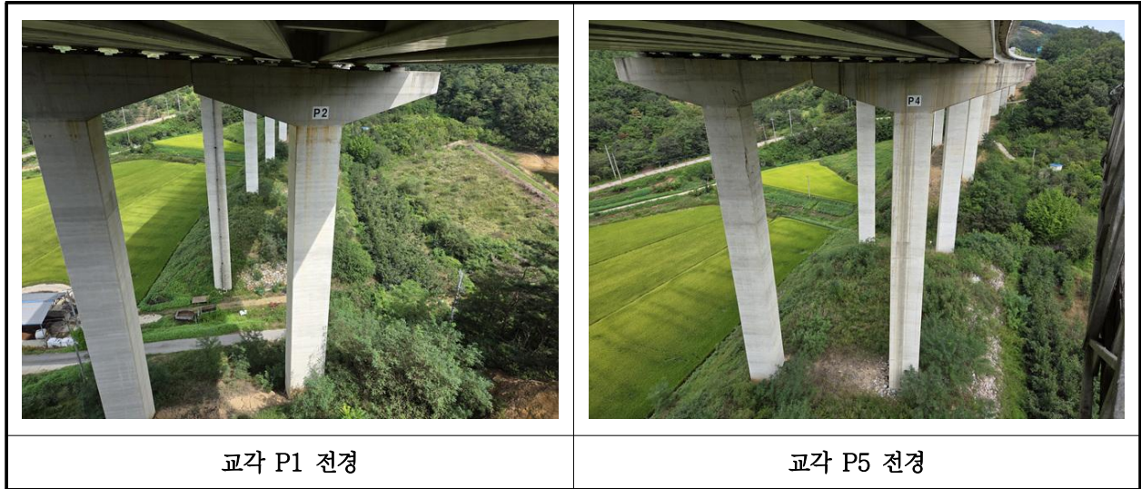
【사진 2.3.37】 교각 전경
