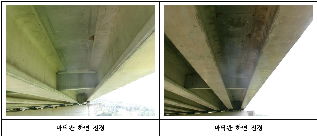
【사진 2.3.2】 바닥판하면 전경
