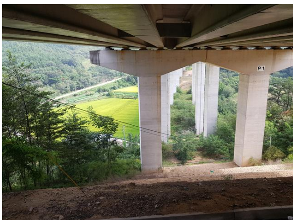
교각 코핑부 상태양호
