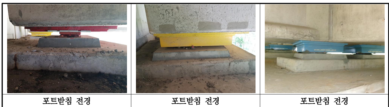
【사진 2.3.40】 교량반침 전경
