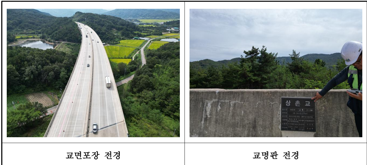
【사진 2.3.20】 교면포장 전경
