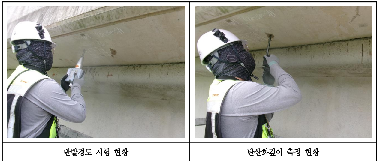
【사진 2.4.1】 콘크리트 내구성조사 현황
