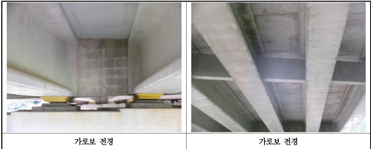
【사진 2.3.33】 가로보 전경
