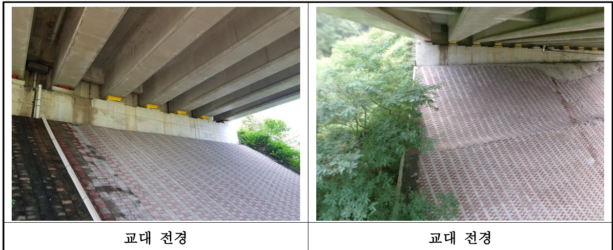
【사진 2.3.8】 교대 전경
