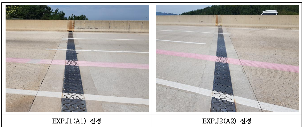
【사진 2.3.44】 신축이음장치 전경
