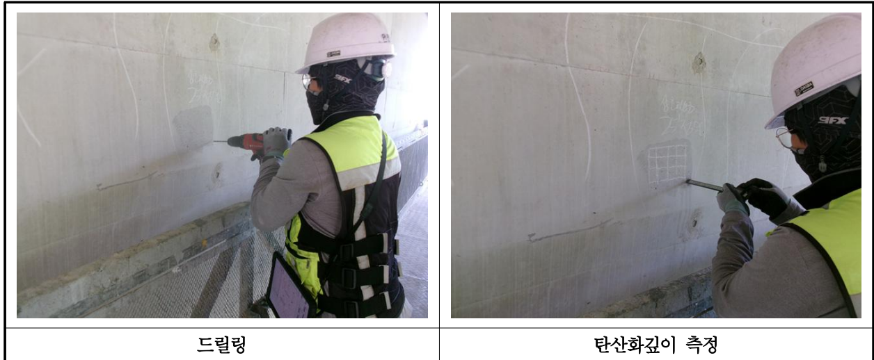
【사진 2.4.3】 탄산화 깊이 측정 현장사진
