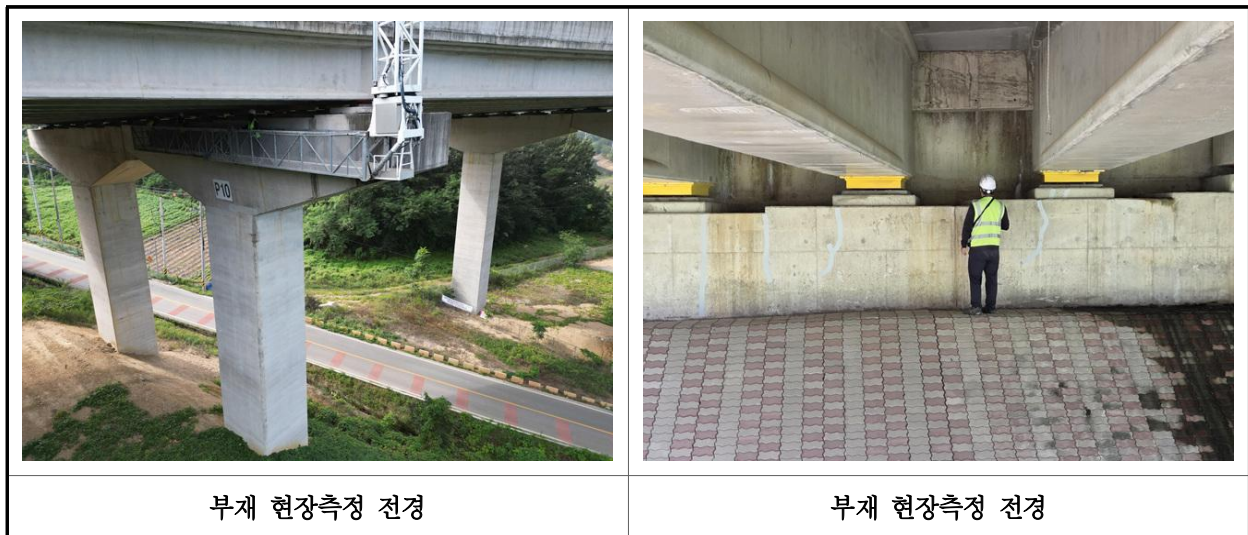
【사진 5.2.1】 부재 현장측정 전경
