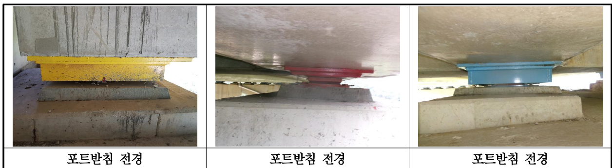
【사진 2.3.13】 교량반침 전경
