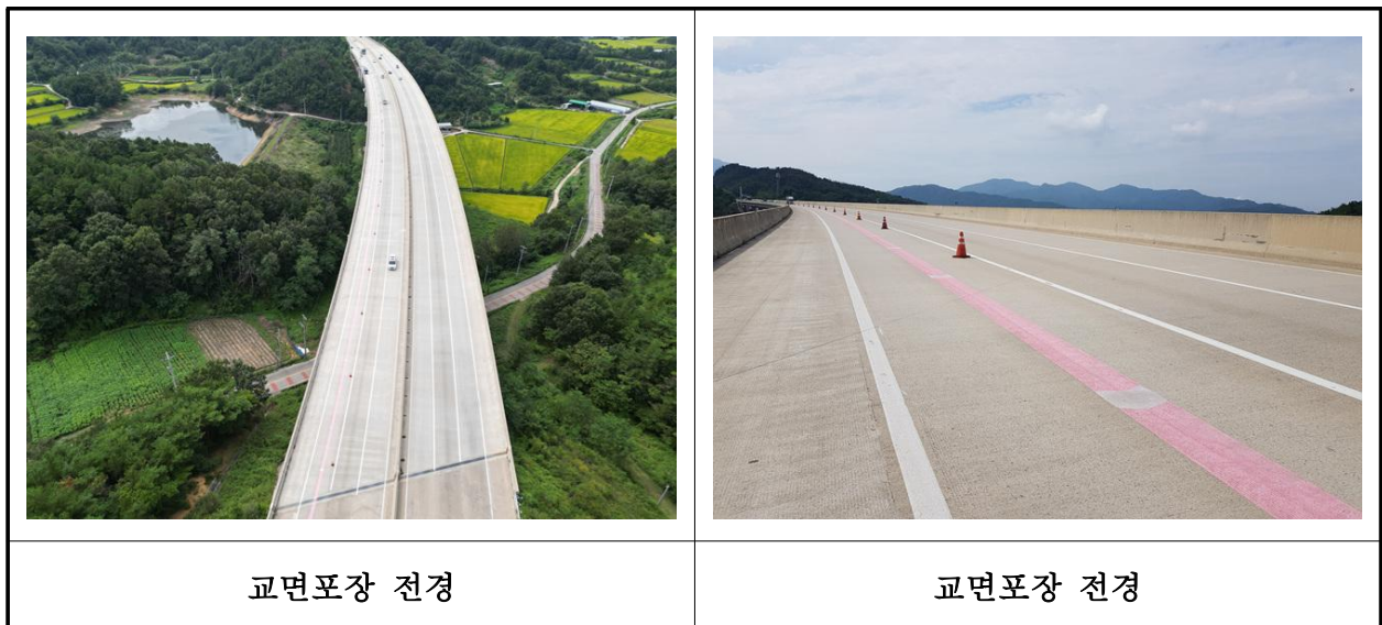
【사진 2.3.47】 교면포장 전경
