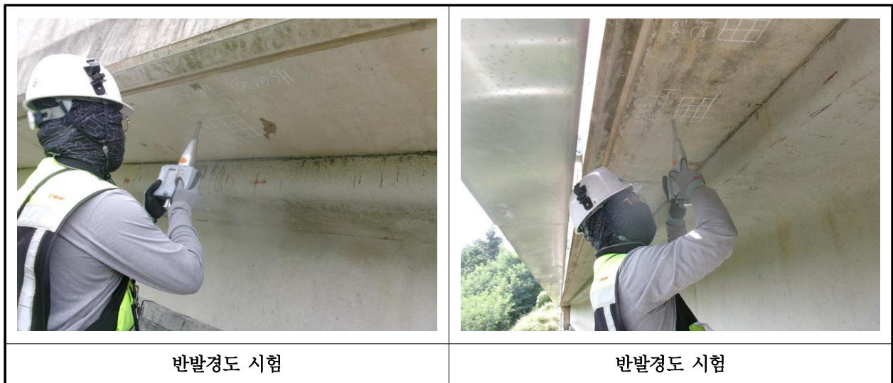
【사진 2.4.2】 반발경도시험 현장사진
