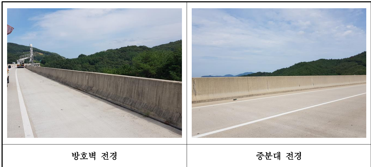
【사진 2.3.51】 방호벽 및 중앙분리대 전경
