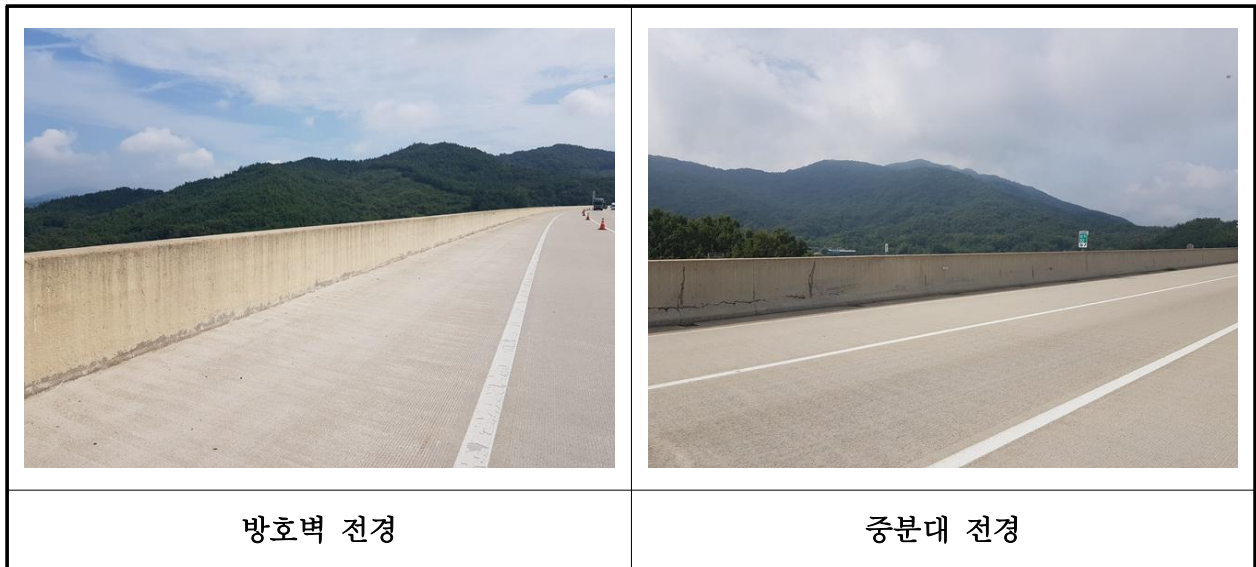
【사진 2.3.24】 방호벽 및 중앙분리대 전경
