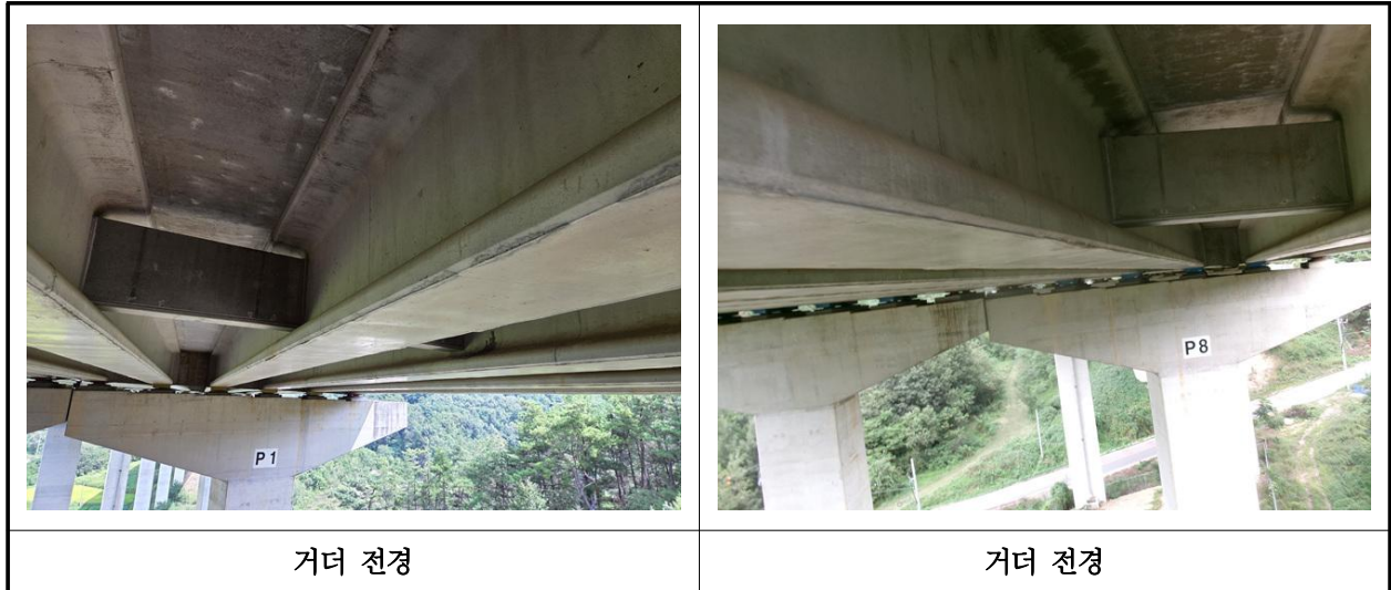
【사진 2.3.31】 거더 전경
