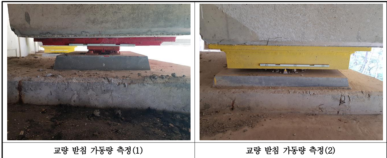
【사진 2.3.43】 교량받침 이동량 측정
