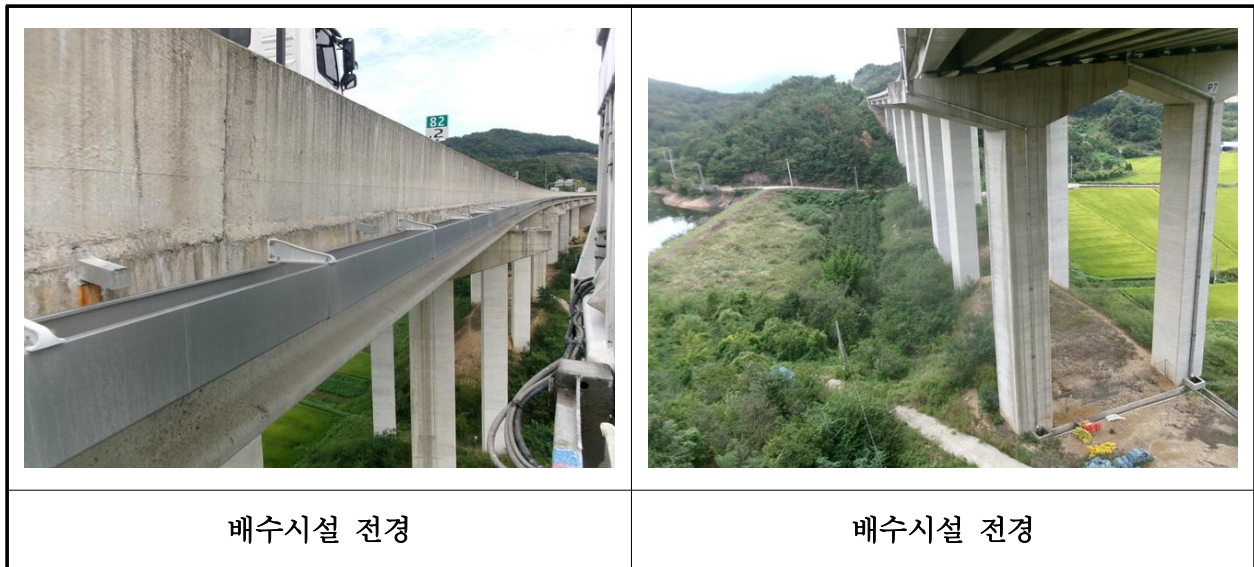
【사진 2.3.49】 배수시설 전경
