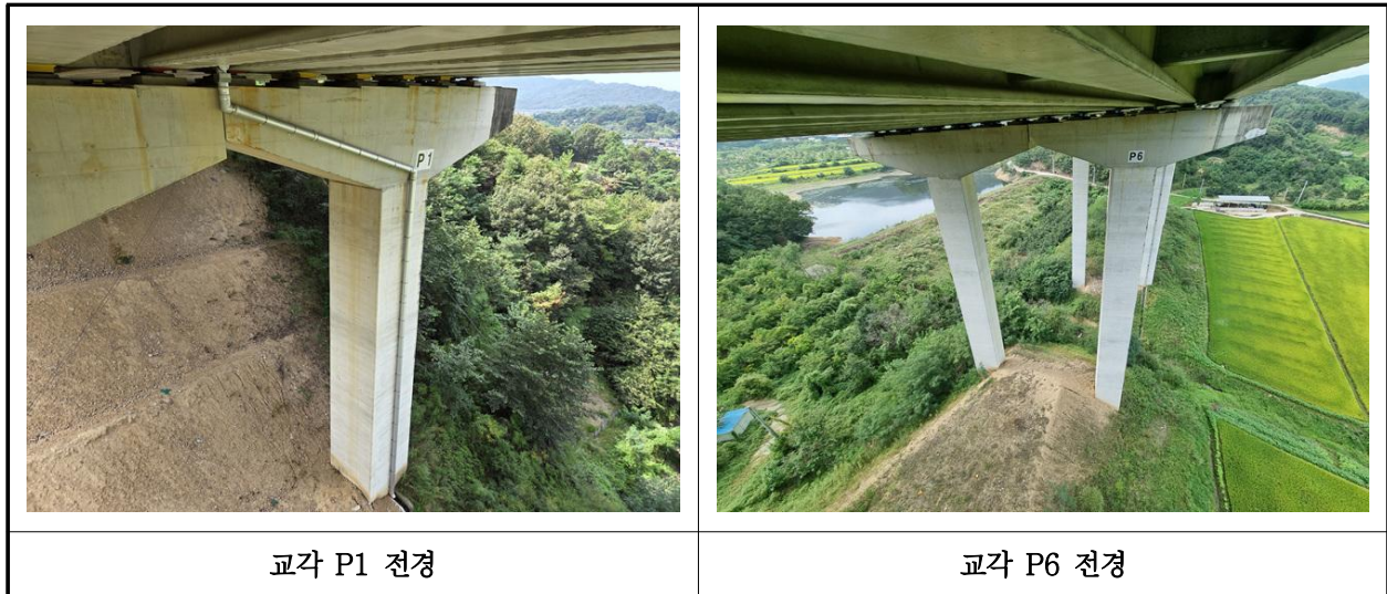
【사진 2.3.10】 교각 전경
